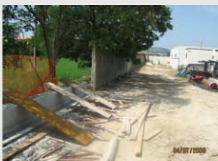
LAVORI RECINZIONE Lavori realizzazione nuova recinzione cabina principale in Loc. Vallettone a Monte Roberto
