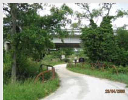
Lungo fiume a Macine di Castelplanio Tratto interessato da Posa turbogas, pista ciclabile e fibra ottica
