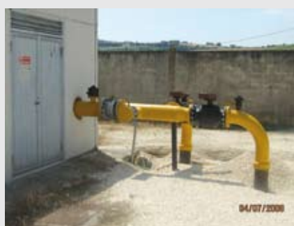
VALVOLE USCITA CABINA Nuovo gruppo valvole in uscita cabina principale in Loc. Vallettone a Monte Roberto
